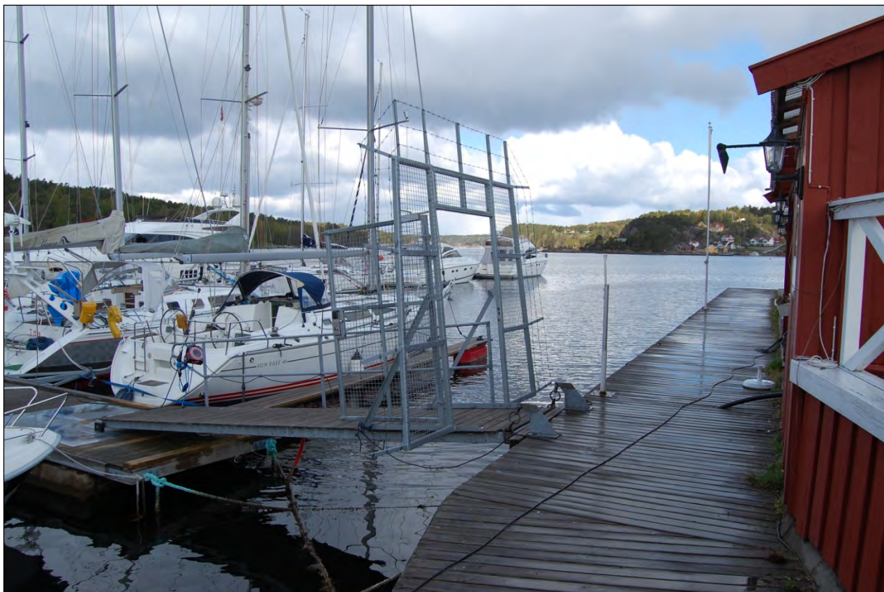
Figur 39. Låsbar port til bryggeanlegget ved Hankø Marina.
