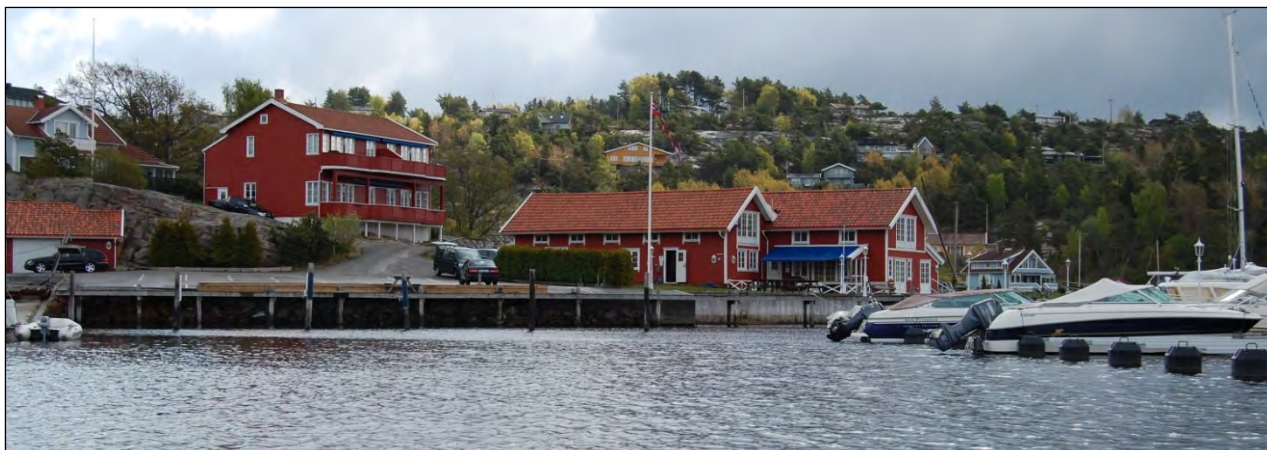
Figur 46. Restaurert bygningsmiljø på Hankøund slipp.
